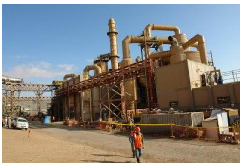
Fundición de Ilo
